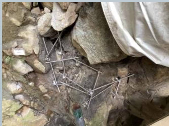
リブアーチ起拱部補強: 補強筋配筋状況
