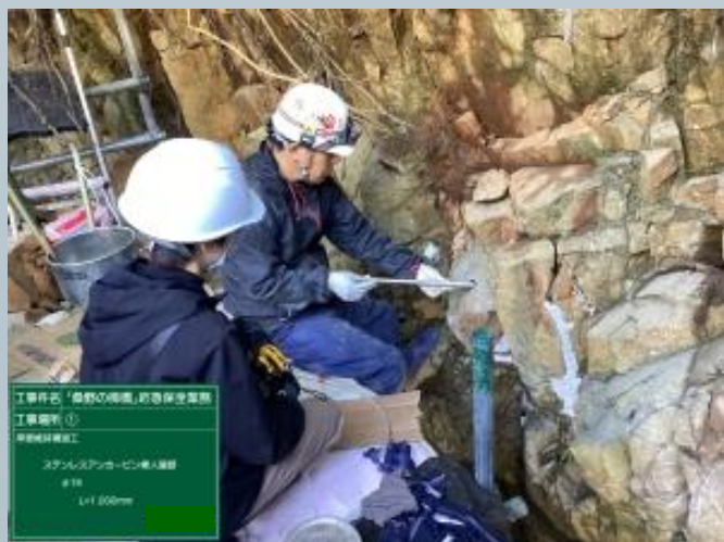
左岸岩盤補強: アンカーピン挿入
