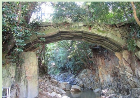
下流側より近景
