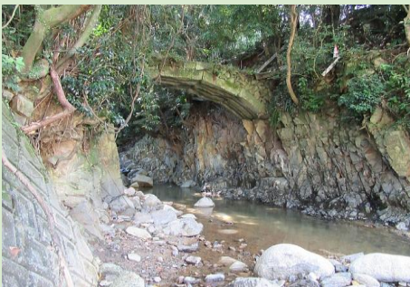
下流側より遠景
