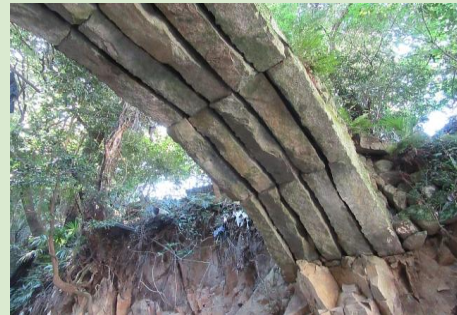
左岸側起拱部
