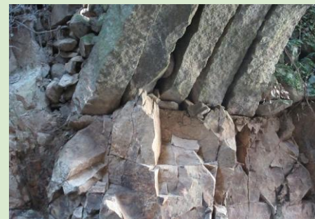
左岸側起拱部
