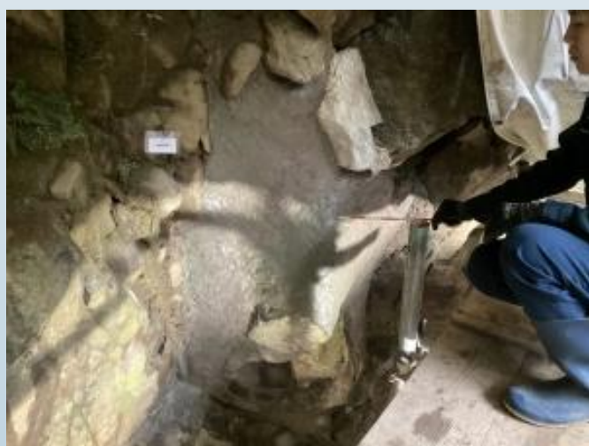
リブアーチ起拱部補強: 擬石充填
