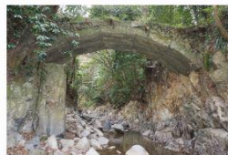
福岡県嘉麻市の指定有形文化財になったリブアーチ式の「桑野の梯橋」。現在、立ち入りは禁止されている
