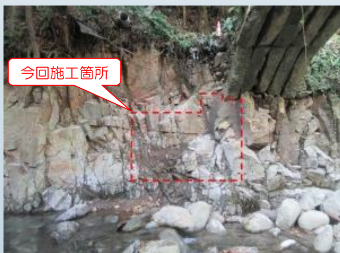
応急保全措置完了
